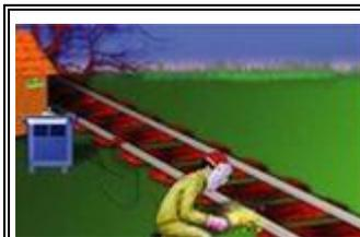
**Запрещается!** Использование в качестве обратного проводника внутренних железнодорожных путей, сети заземления или зануления, коммуникаций и технологического оборудования
