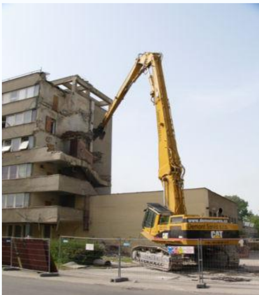
Экскаватор CATERPILAR с манипулятором осуществляет демонтажные работы
