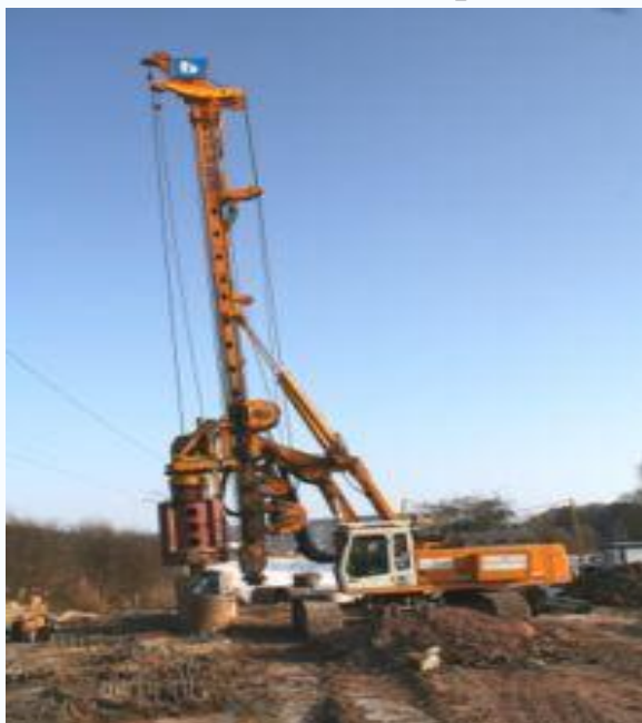
Экскаватор со свайным копром
